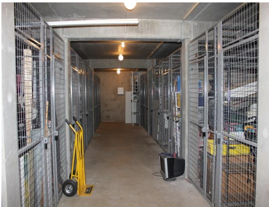
Kælderrum med metalbure til opbevaring. Støbt betongulv.
