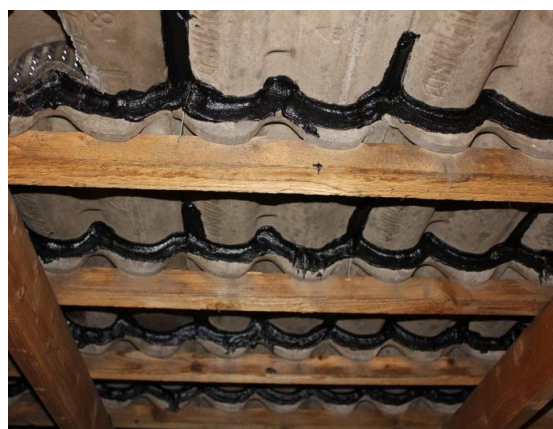
Tagstenene ses understrøget med en bitumenbaseret specialfugemasse.
