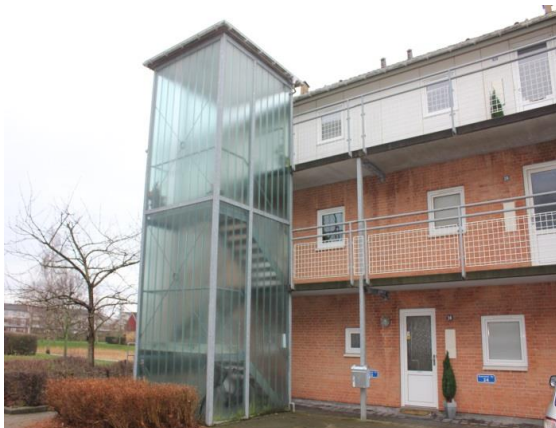
Indgangsdøre i nordvendt facade. Udvendige døre er udført i plast.
