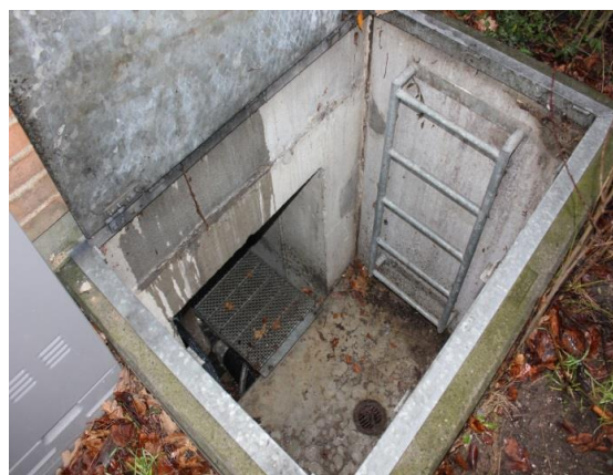
Udvendig nedgang til ingeniørgang under 2 bygninger (Lærkehegnet 2-20 og 42-60) med afløb.
