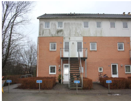
Vinduer nordvendte mod p-plads.
