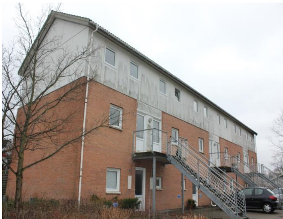
Vinduer nordvendte mod p-plads. Vinduer er udført i plast.
