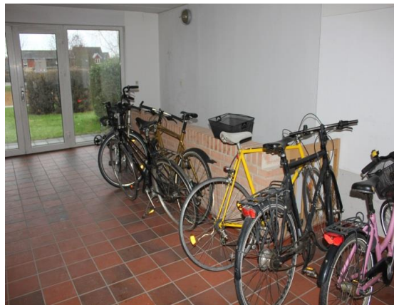
Gennemgang i bygning (nr. 201-249).
