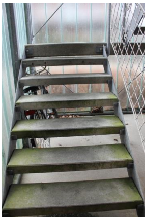
Udvendig trappe i trappetårn.
