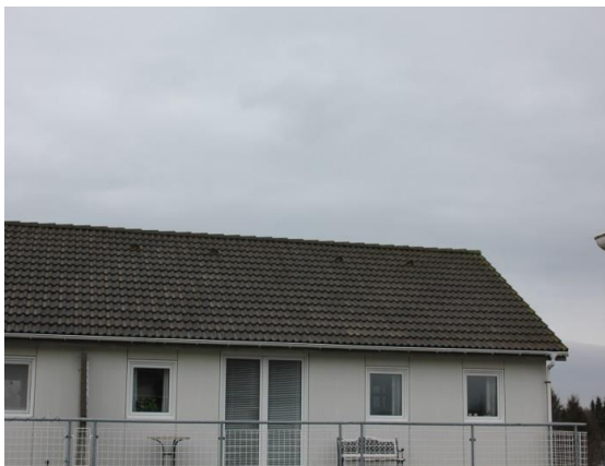
Ejendommens tagbelægning er udført med betontagsten.
