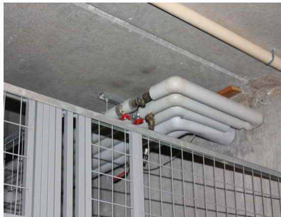
Kælderloft af betonelementer. Vægge af støbt beton.
