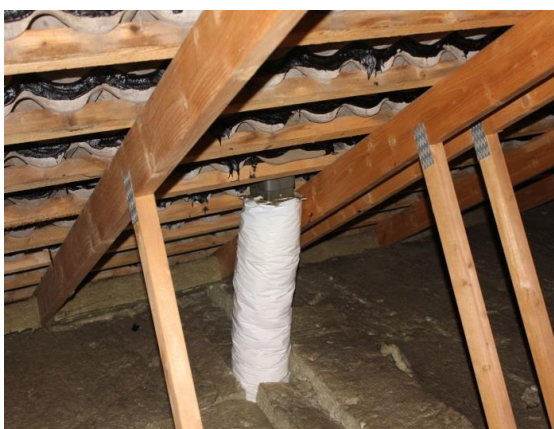
Tagrummet fremstår tørt og godt ventileret.
